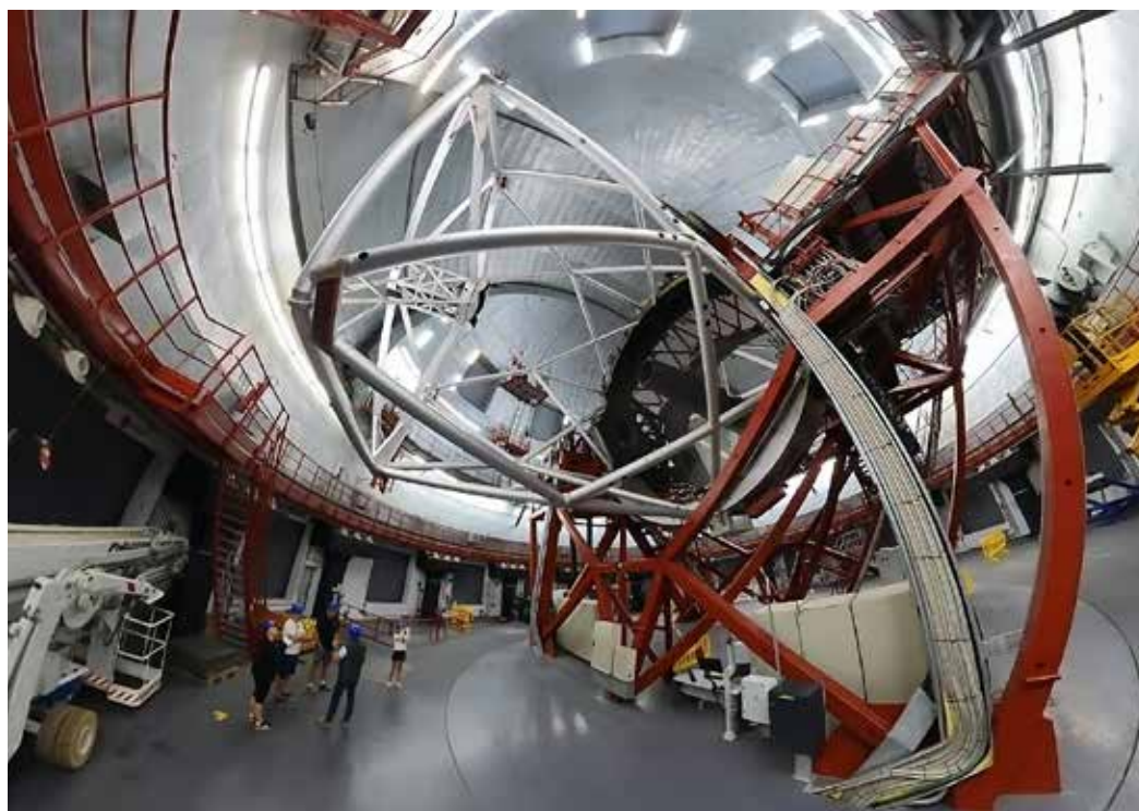
Vue générale du GTC sous sa coupole
